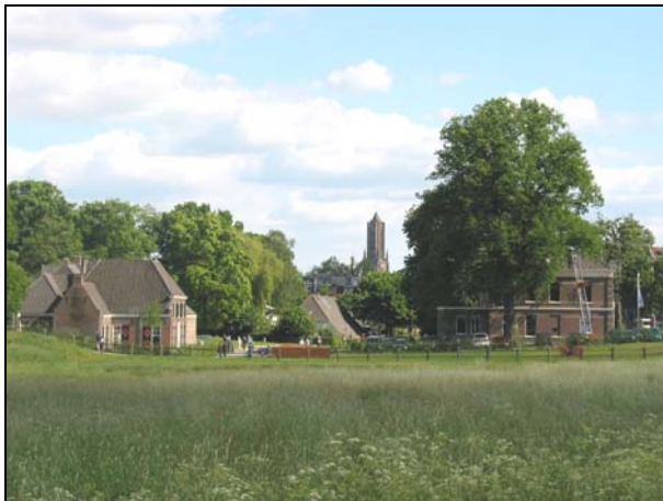
foto van de situatie, met nauwelijks zichtbaar, de roestkleurige, stalen verbindingen tussen boven- en ondergrond.
